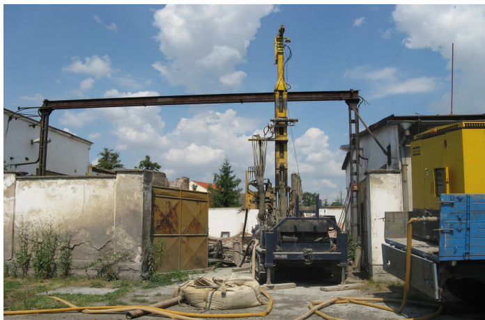
Obrázek 2: Realizace průzkumných prací v rámci průzkumu v roce 2010
